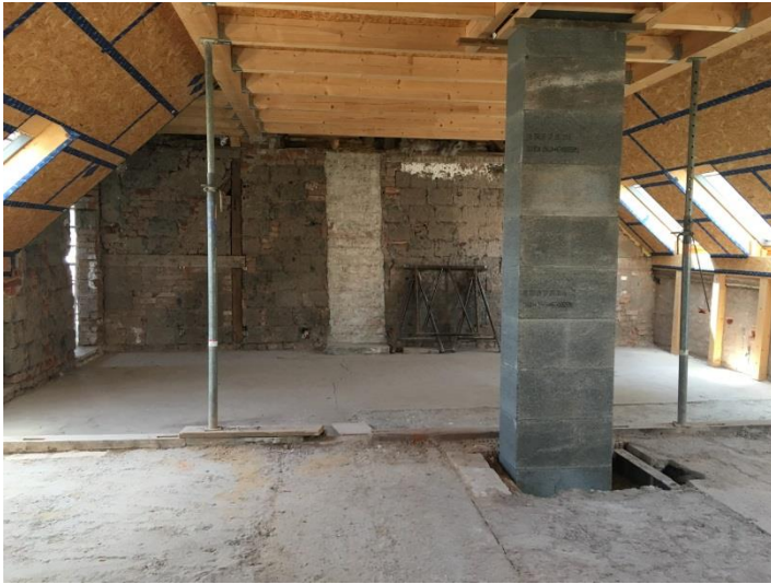
Dachgeschoss Richtung Süden
